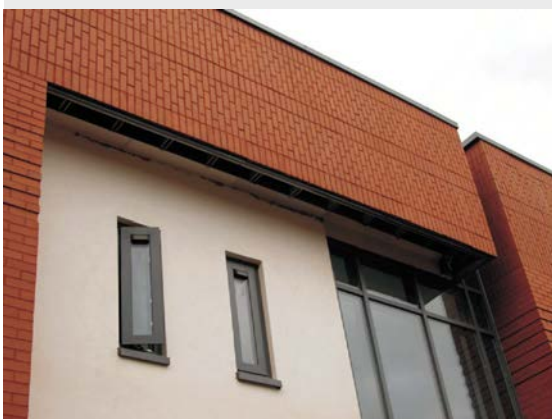
图 5: 由砖墙支撑系统支撑的垂直对缝砌法砖墙的建造
