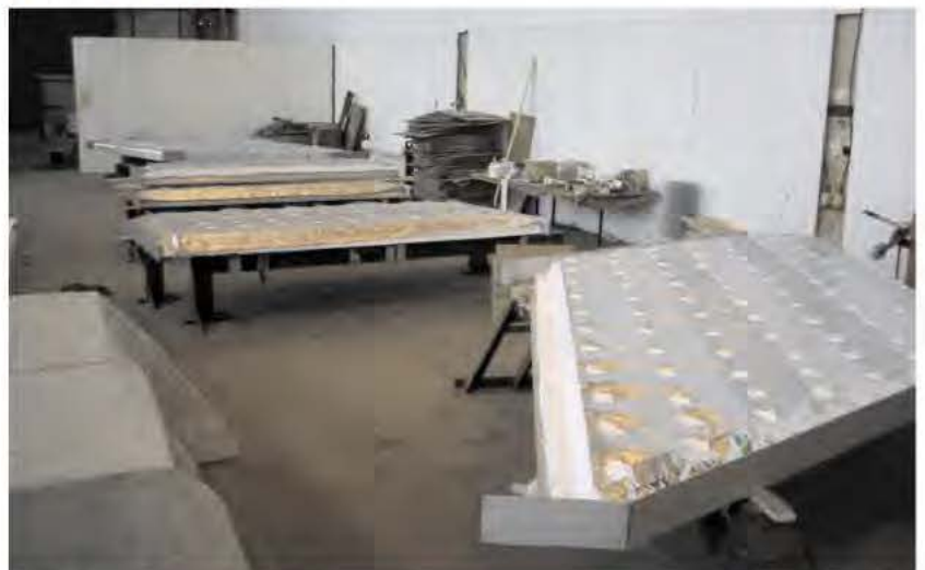
图片 7: 在墙面板内安放隔热层
