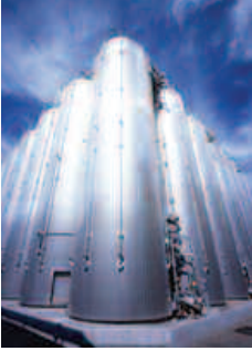
Soya sos üretimi safhasında kullanılan fermentasyon -mayalama- tankları, aksi halde korozyona engel olunmasındaki zorluklar nedeniyle, super austenitik paslanmaz çeliklerden yapılmaktadır. Resimde görülen örnekte olduğu gibi, üreticinin tek seçeneği olan % 23 Krom, % 25 Nikel ve % 5,5 Molybden içeren bir kalite kullanması gerekmektedir. Fotoğraf: Nippon Yakın Kogyo Co. Ltd.
