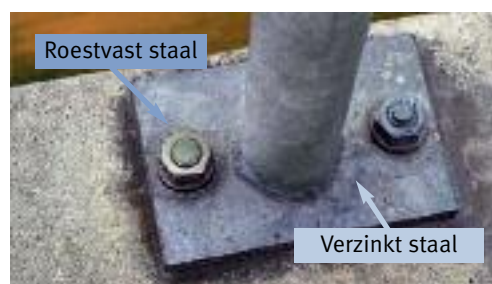
Figuur 8a, 8b: Praktische toepassingen van de principes getoond in Figuur 6 : gegalvaniseerd staal in contact met roestvast staal in een kust omgeving.
