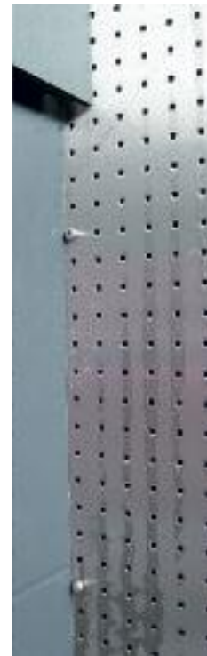
Figuur 11: Om galvanische corrosie te voorkomen, zouden enkel roestvast stalen bevestigingsmaterialen gebruikt mogen worden bij roestvast stalen panelen.
