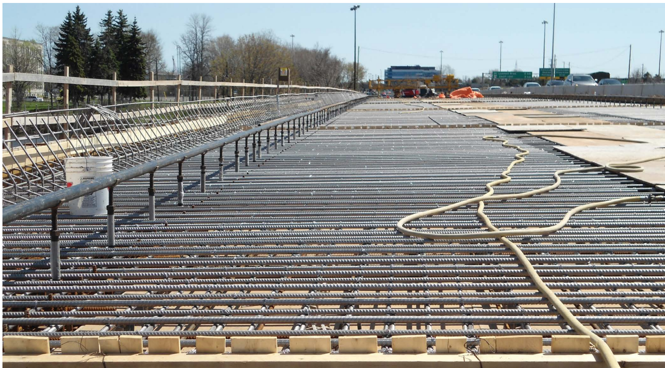
在冬季使用除冰盐的地区，不锈钢筋能带来好处。图：Frank Smith
