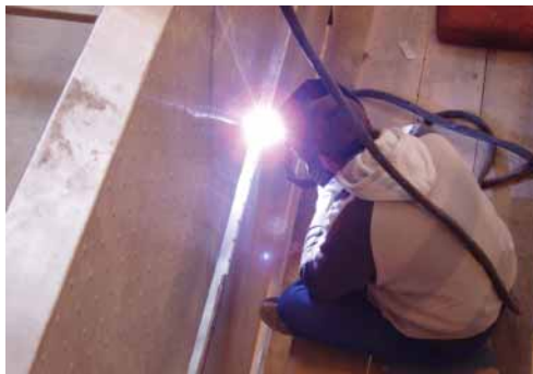
Montážní svařování konstrukce plaveckého bazénu z korozivzdorné oceli.
