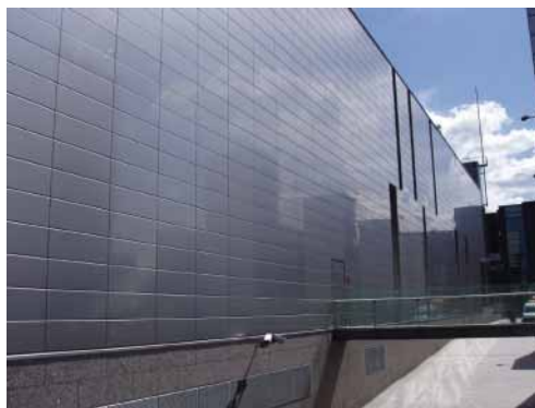
Použití korozivzdorné oceli od stejného dodavatele a ze stejné šarže zajistí jednotnost povrchů.
