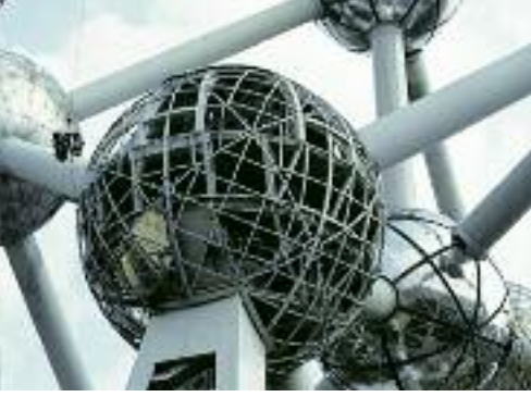
Şekil 16: Atomium Brussels'de paslanmaz çelik dış panellerin karbon çeliği iskelet üzerine bağlan- ması.
