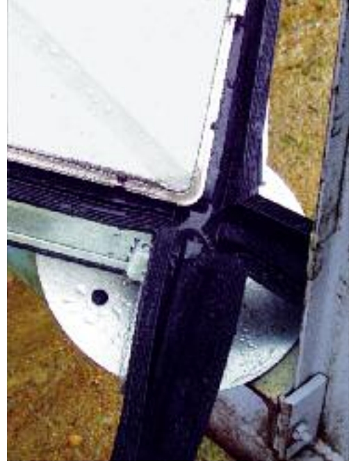
Şekil 17: Paslanmaz çelik dış pa- nel, içerideki galvanizli çelik panelden uygun bağlantılar vasıtasıyla izole edilmiştir.
