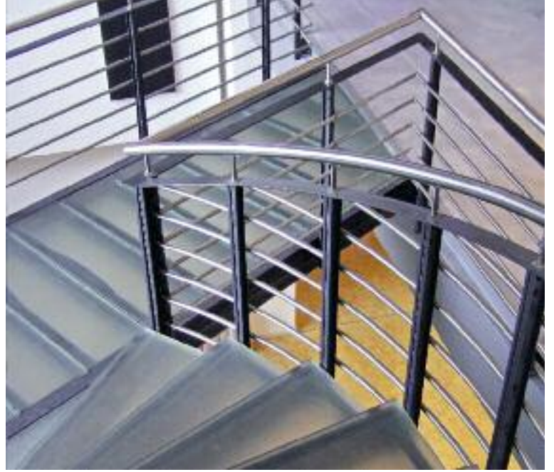
Şekil 5: Normal biçimde ısıtılan ve havalandırılan iç mekân ortamlarında genel anlamda elektrolitlerin bulunmaması sebebiyle, bu koşullar altında paslanmaz çeliğin boyanmış karbon çeliği gibi diğer metalik malzemelerle kombinasyonu genellikle bir galvanik korozyon riski içermez.
