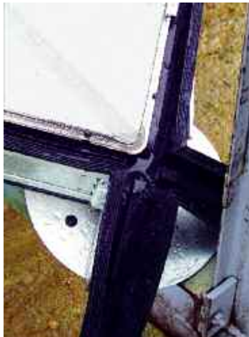
Obrázek 17: Venkovní panel z korozi- vzdorné oceli je vhodnými spoji izolován od vnitřního panelu z pozinkované oceli.
