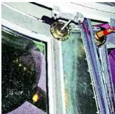
Obrázek 19: Při zamezení průniku vlhkosti nehrozí galvanická koróze vnějšího obložení z korozivzdorné oceli připev- něného k vnitřní konstrukci z uhlíkové oceli.
