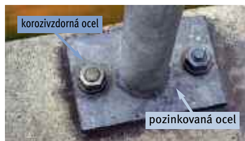
Obrázek 8a, 8b: Šrouby z korozivzdorné oceli na mnohem větších součástech z pozinkované oceli normálně korozi nevyvolávají.
