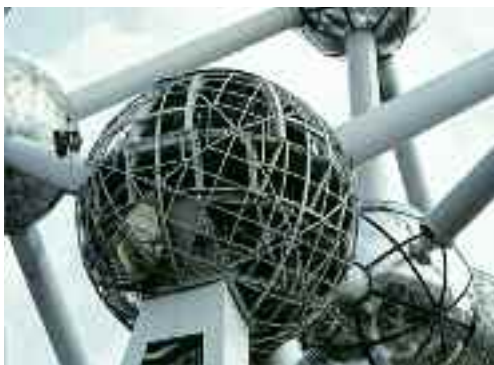
Obrázek 16: Atomium v Bruselu má venkovní panely z korozi- vzdorné oceli připevněné na konstrukci z uhlíkové oceli
