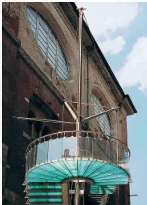
*Nel punto di giunzione, l'antenna si dirama in tre "dita" alle quali è appeso l'impalcato dei gradini.*
