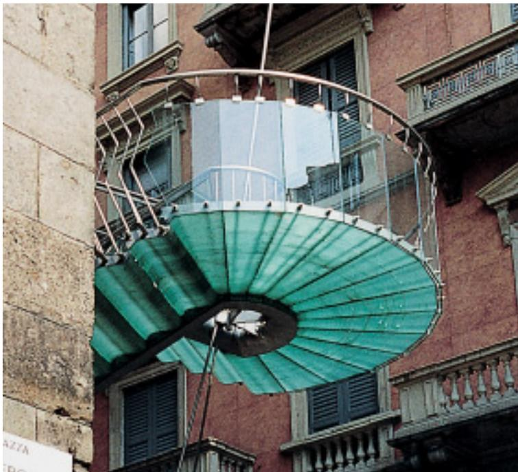
*Dato che la scala è sostenuta solo da una unica antenna ramificata, la strada sottostante è stata mantenuta in gran parte libera da ostacoli fissi.*
