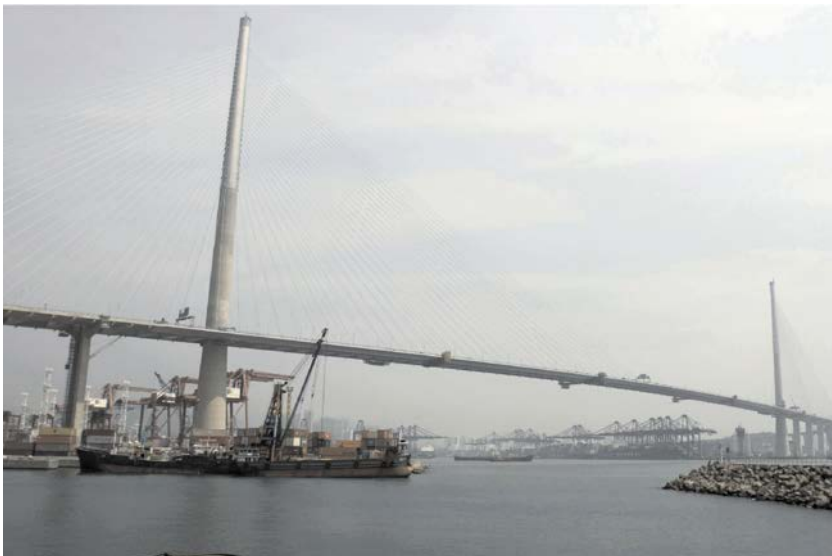
图片 1: 昂船洲大桥全貌
