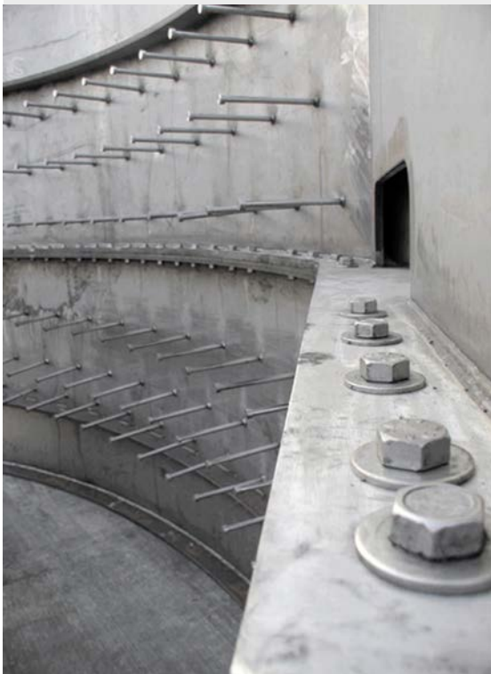
图片 6: 边线法兰的连接
