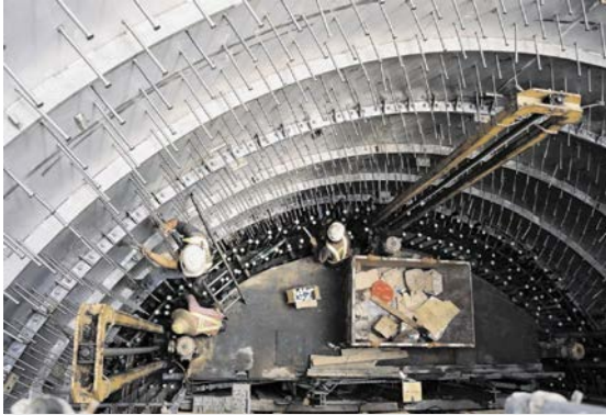
图片 5: 桥塔内的剪力连接件
