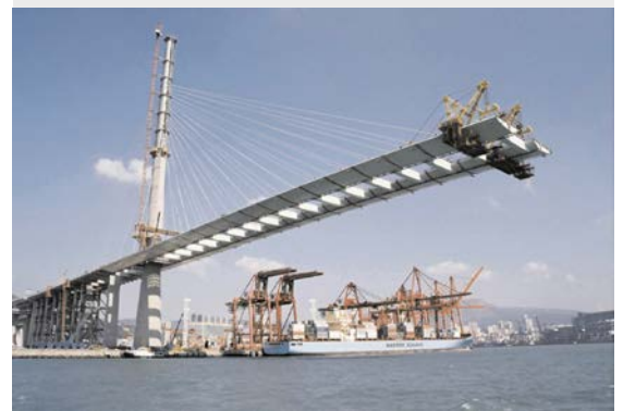
图片 4: 建设中的大桥
