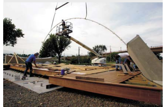
图 5: 第一个弯曲构件的安装(图片来源:舒伯特俱乐部)
