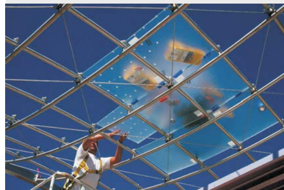
图 8: 玻璃顶板的安放 (照片来源:舒伯特俱乐部)
