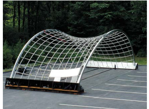
图 3: 这个壳形构造首先在制造商的停车场进行了组装以确保装配良好(图片来源:Tim Eliassen)
