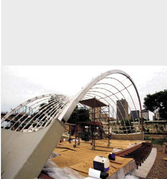
图 6: 弯曲边梁和网架构件的安装 (图片来源: 舒伯特俱乐部)
