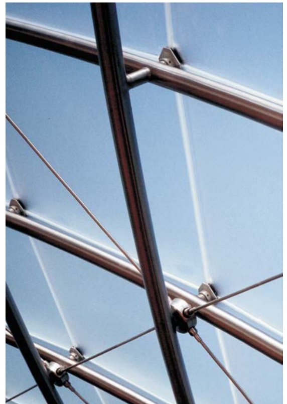
图 2: 壳形演奏场内的不锈钢构件和节点照片(照片来源:James Carpenter Design Associates and Shane McCormick)
