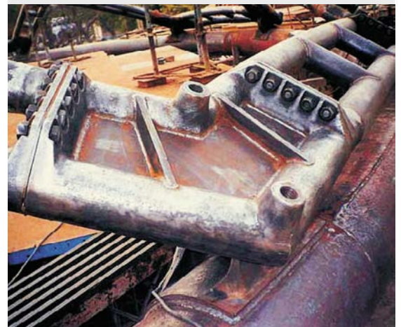
图 9: 施工期间在现场装配的钢构件
