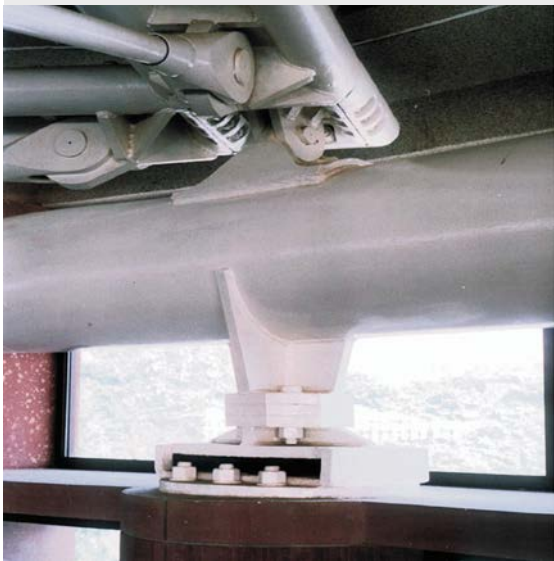
图 7: VIP 圆顶的支撑系统
