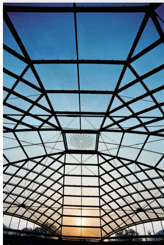
图 3: 不锈钢和玻璃构造中央主要圆顶的照片
