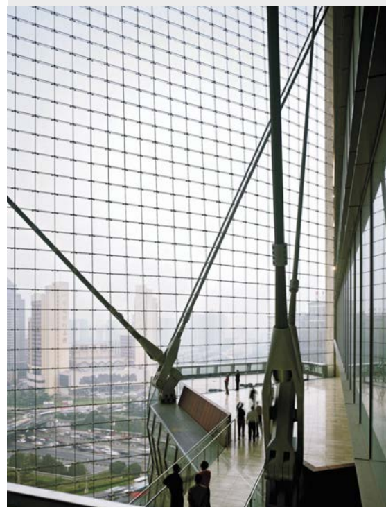
图 2: 主索网玻璃幕墙及其主要的 V 形钢缆 (照片来源: Tim Griffiths, Skidmore, Owings & Merrill LLP)
