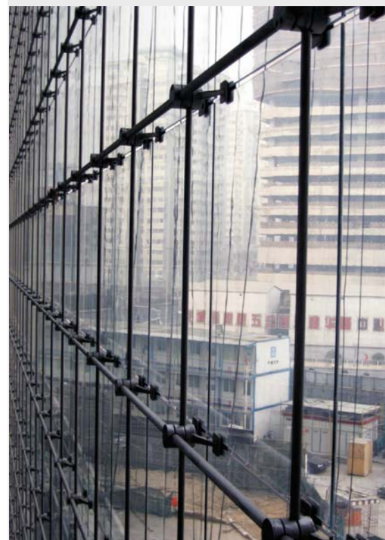
图 3: 索网部件照片,包括支撑加固部分 (照片来源: Skidmore, Owings & Merrill LLP)
