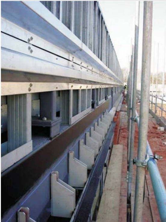
图 4: 图 2 所示支撑系统的建造
