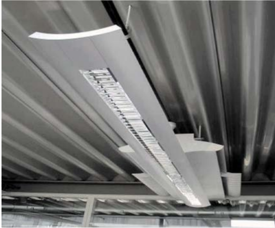
图片 6: 悬挂在压型板的照明和空调系统
