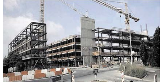
图片 9: 建设钢铁结构框架
