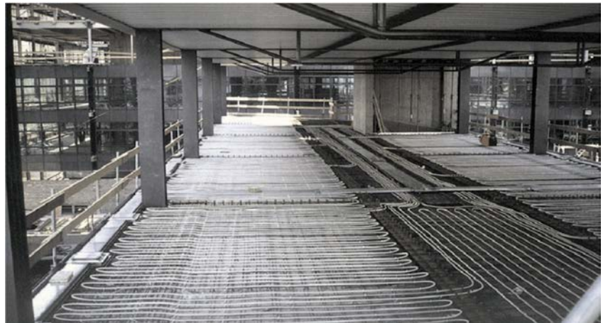
图片 8: 安装在楼盖板内的水冷 / 热管道系统
