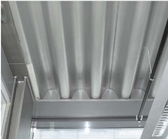
图片 7: 压型板的角部细节
