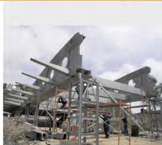
图片 11: 对主要结构进行临时支撑
