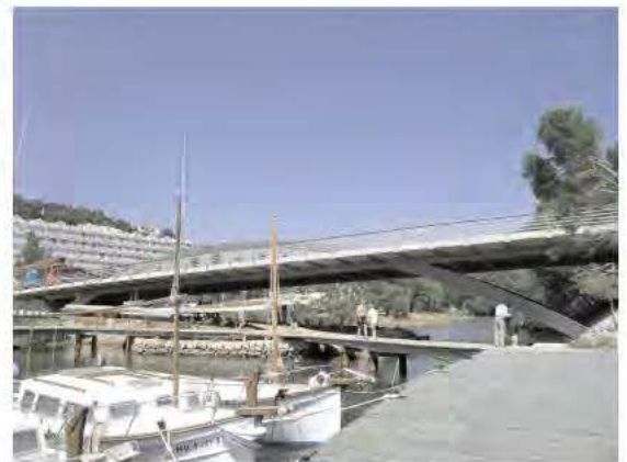
图片 1: 桥梁全貌
